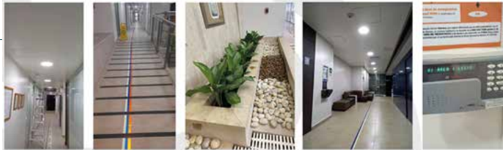
CIRCULACIONES, SALAS DE ESPERA, ORNAMENTACIÓN, SEÑALIZACIÓN, SISTEMA SENSORES INCENDIO
